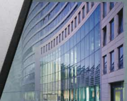
Immeubles de bureaux
