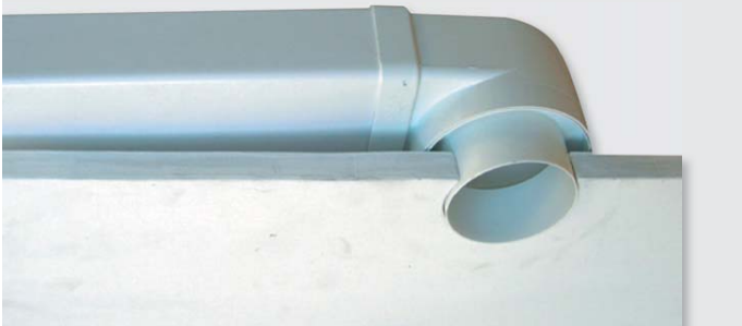
Montage en faux plafonds
