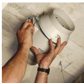
Insérer le corps moteur-hélice.
