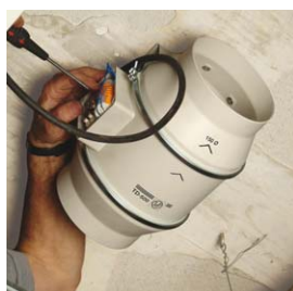
Réaliser les connections.
